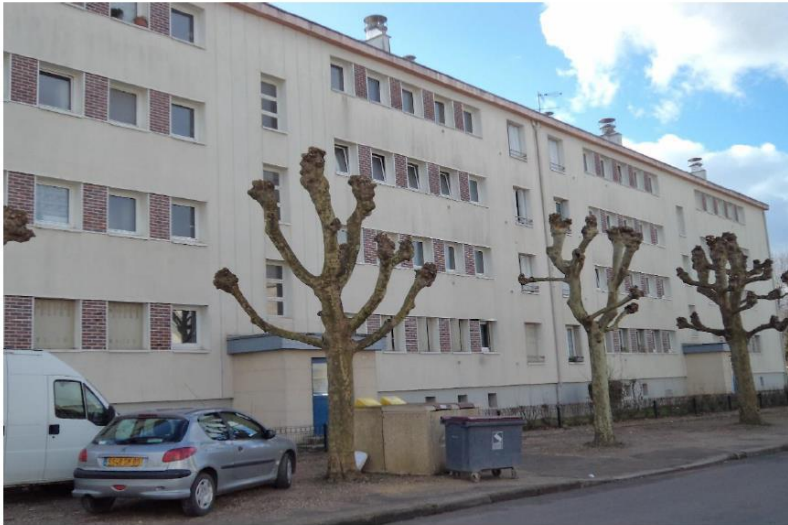
Bâtiment L – 6 et 8 rue Stéphane Mallarmé
