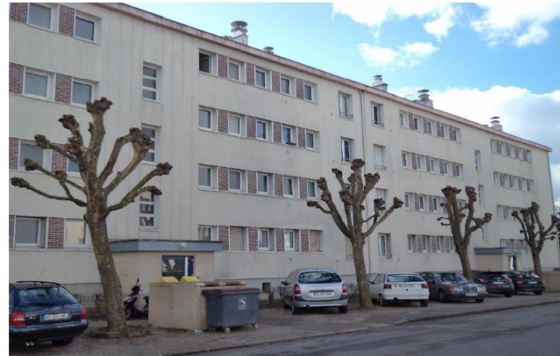
Bâtiment M – 10 et 12 rue Stéphane Mallarmé
